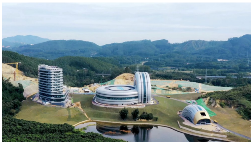
中建三局一公司承建的广州航空轮胎动力学研究中心项目竣工。项目位于广州市黄埔区，总建筑面积3.8万平方米，以航空轮胎动力学大科学装置为核心，建设与之配套的航空轮胎展示中心、硬核科技中心。项目将助力科研人员依托中国科学院长春应用化学研究所及该所广州黄埔先进材料研究院的科研优势，力求在基础材料、基础理论上突破，从而实现我国航空轮胎关键技术自主可控。（闻恒海）
