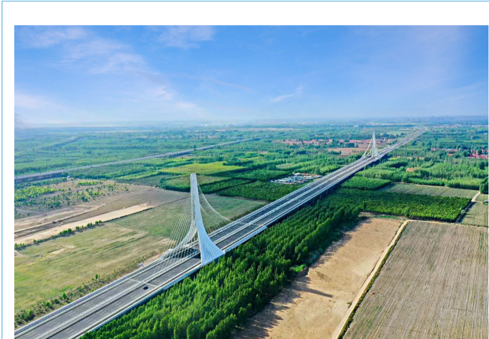
中建二局安装公司参建的廊坊临空经济区永定河特大桥项目日前全线贯通。项目地处京津冀核心区,属于城市主干道路等级,整体桥长2047米,宽47米,双向8车道。作为廊坊市重点工程,大桥优雅轻盈的现代造型与远山近水交相辉映,已成为廊坊临空经济区一道亮丽的风景线。项目建成后将成为联动临空经济区南北的重要桥梁,为构建一体化的综合交通体系、加快临空各功能区一体化建设发展发挥重要作用。(周双双)
