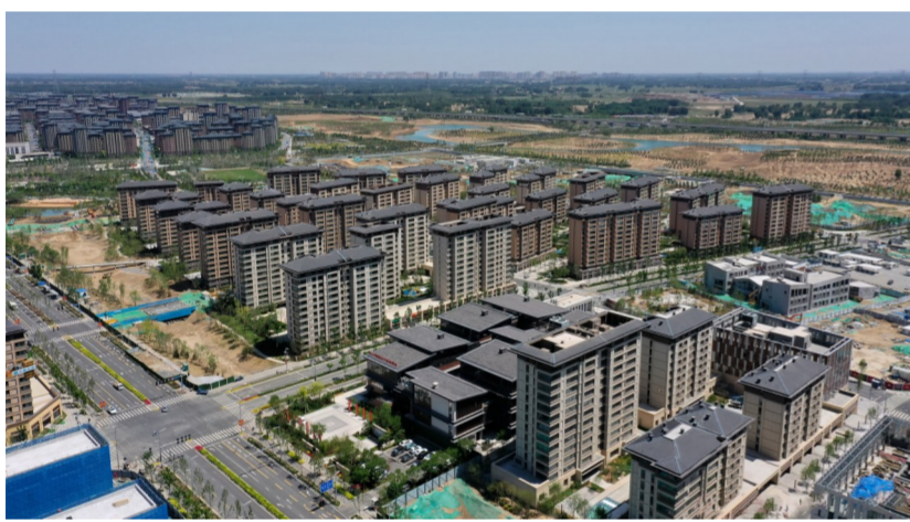
由中建二局四公司承建河北雄安新区2#地项目通过竣工验收。作为雄安新区首批市场化开发地块和首个住房市场化模式建设项目,项目建成后将成为雄安新区发挥“典范城市”引领作用和示范效应的重要组成部分,极大提升居民生活幸福指数。(杨砚铄)
