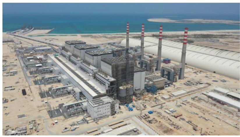
由中建三局二公司承建的迪拜哈斯彦电站项目4号机组并网成功。迪拜哈斯彦电站项目位于迪拜杰布布拉区,是世界上第一个实现双燃料满负荷供电的电站。项目4台机组全部投入商业运行后,将为迪拜提供20%的电力能源。项目是“一带一路”国际合作重大工程,也是中东首个清洁能源电站。(任艳峰)
