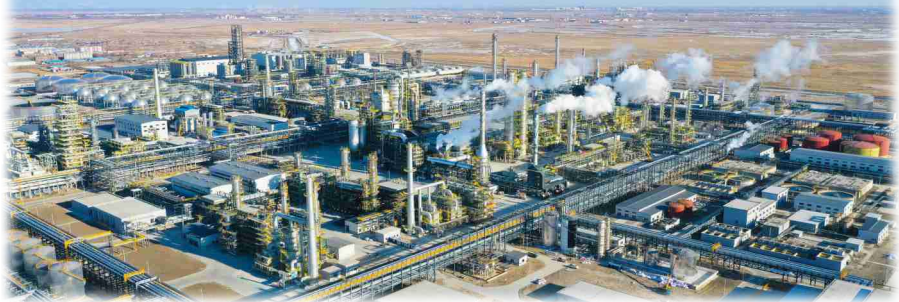
大庆龙油石化施工总承包项目
