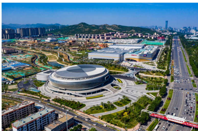
5月29日，中建八局承建的山东省规模最大的文旅综合体——济南融创文旅城开业。项目建筑面积约535万平方米，其中停车楼装配率达67%，可同时容纳6000辆车停放，是全国最大的装配整体式停车楼。(李贺雷)
