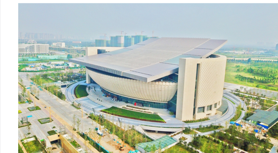
近日，中建三局总承包公司承建的郑州博物馆新馆开馆。该项目是全国单体最大博物馆，也是国内首次在博物馆类建筑中应用BRB连梁阻尼器的主体结构减震技术，使博物馆使用寿命超100年，助力郑州国家中心城市建设。(董森)
