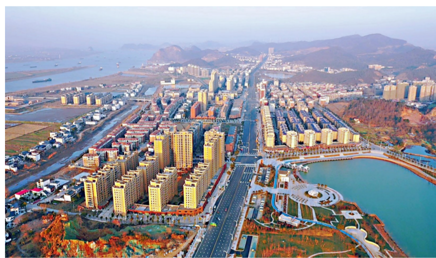
近日，中建二局西南公司承建的长江最美岸线江西彭泽段示范项目城区配套主干管网改造工程龙城大道实现全线通车。(邹园、李果)
