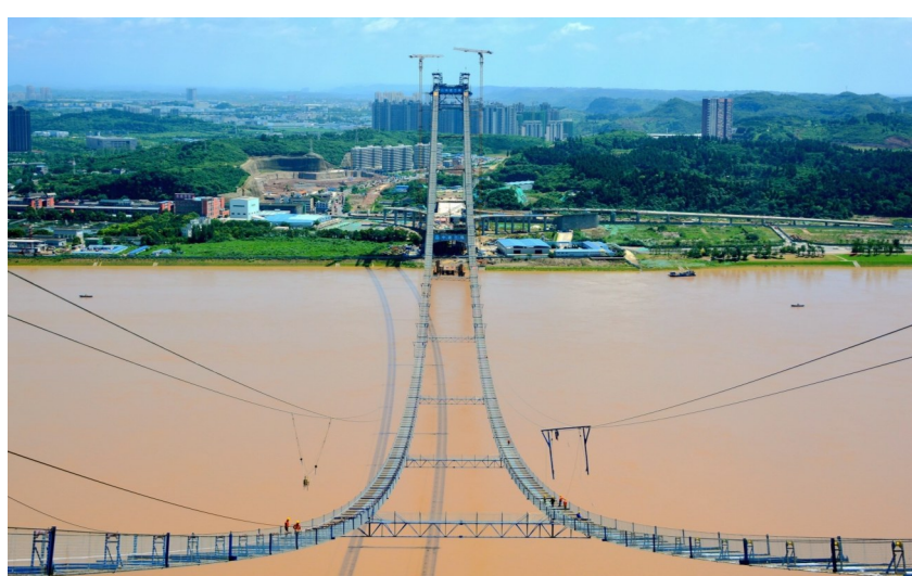
近日，由中建三局投资建设的中国建筑首座主跨千米级长江特大桥——湖北宜昌伍家岗长江大桥进入上部结构施工阶段。(孙春明、徐诗云)
