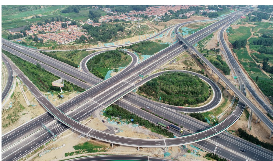
近日，中建八局二公司承建的京沪高速改扩建项目菜芜枢纽立交桥全线通车。该立交桥采用半苜蓿叶+半定向匝道组合设计，大幅提升了道路承载能力。(张燕、陈怀宇)
