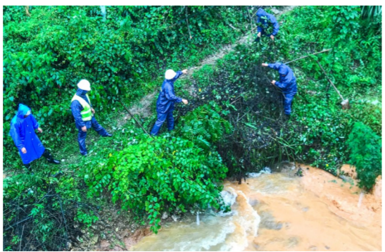
7月8日下午，中建交通江西公司景德镇项目附近铁路低洼处蓄水严重，危及铁路运行安全。项目部紧急配合铁路部门开挖沟渠，增开排水口，将积水导入附近涵洞，及时解决隐患。(交通)
