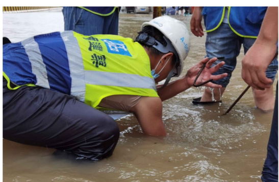
近日，中建三局湖北葛店新城项目组织青年员工，在工地周边开挖排水沟，对积水严重处下水管道进行疏通、清理，协助交管部门维持交通秩序。(郭磊)
