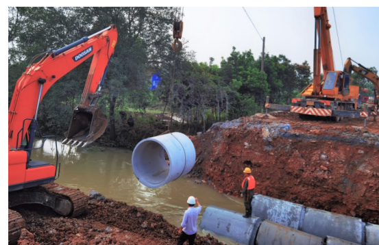
近日，湖北荆门突降暴雨，中建五局土木公司207国道项目迅速组织挖机设备40余台，对涨水河道、沟渠增设排水管道，组织农田排水，出动卡车帮助村民转运物资，保障了村民生命财产安全。(刘重、雷叶)
