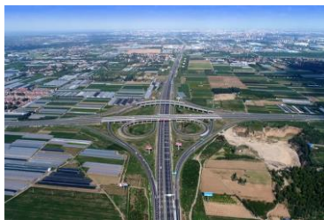
济青高速改扩建工程
