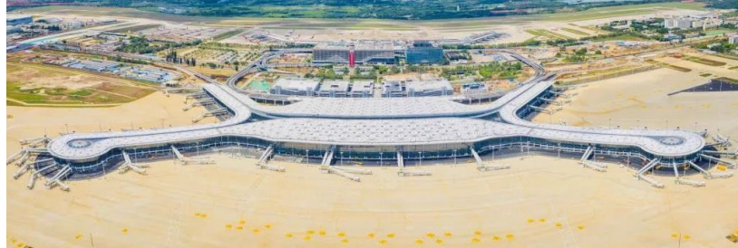
海口美兰国际机场二期扩建项目主体工程完工
