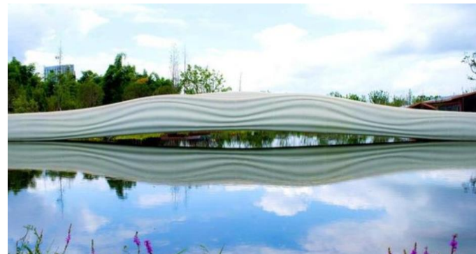
图：高分子3D打印桥“流云桥”
