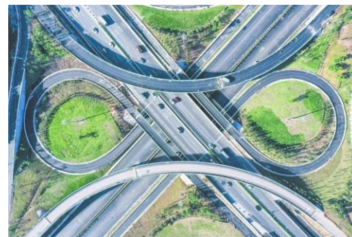
重庆市快速路二横线西段项目
