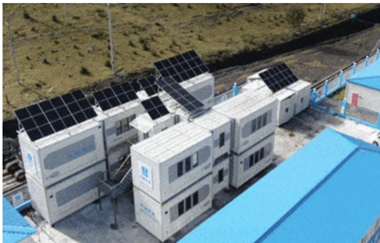
图：高海拔增压补氧模块化建筑群（零海拔屋）
